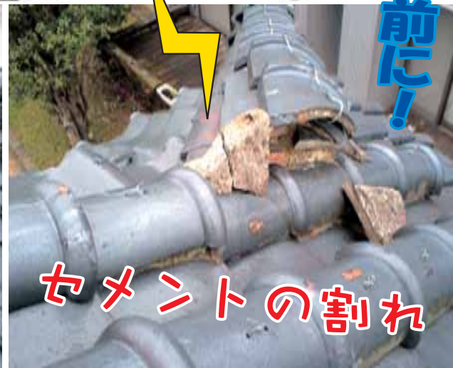
瓦のひび割れ・欠け
